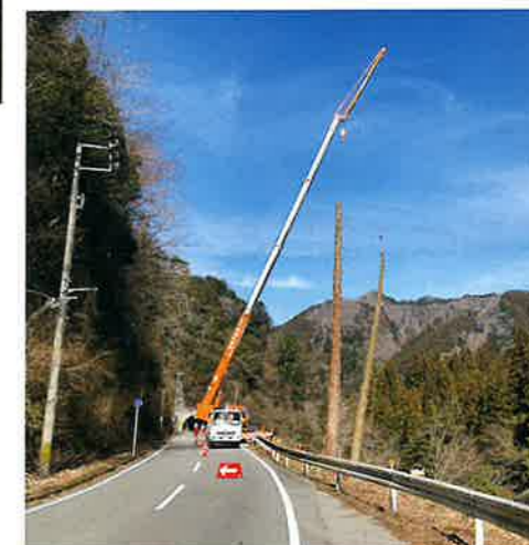
クレーンを使用した伐出作業
